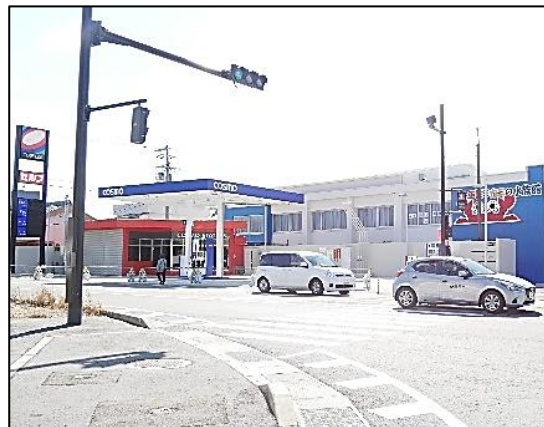
写真-1 新設されたガソリンスタンド
