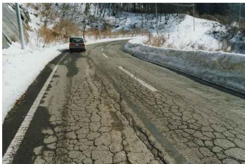
図 1-2 凍上による舗装面の損傷状況 2)
