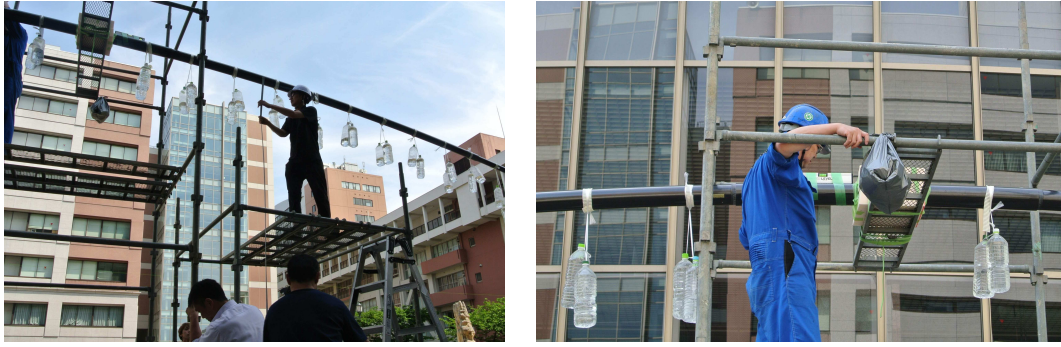
図 11 主桁の荷重試験の様子
