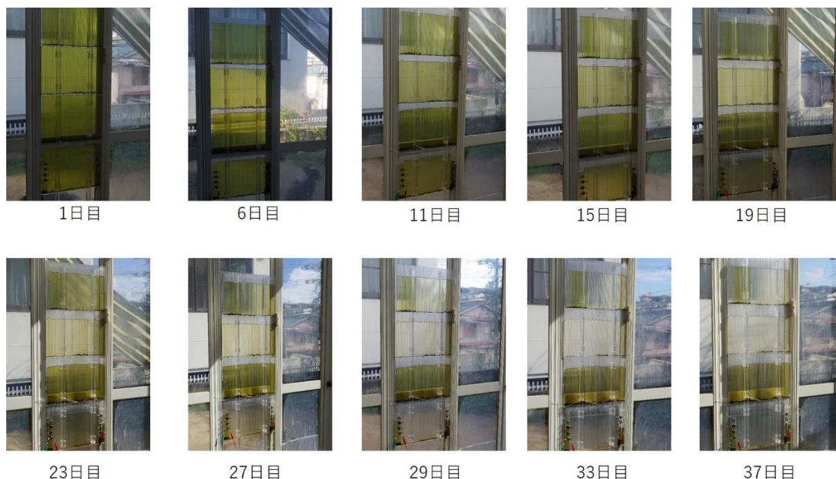
図 13 光合成窓の外観の経時変化
