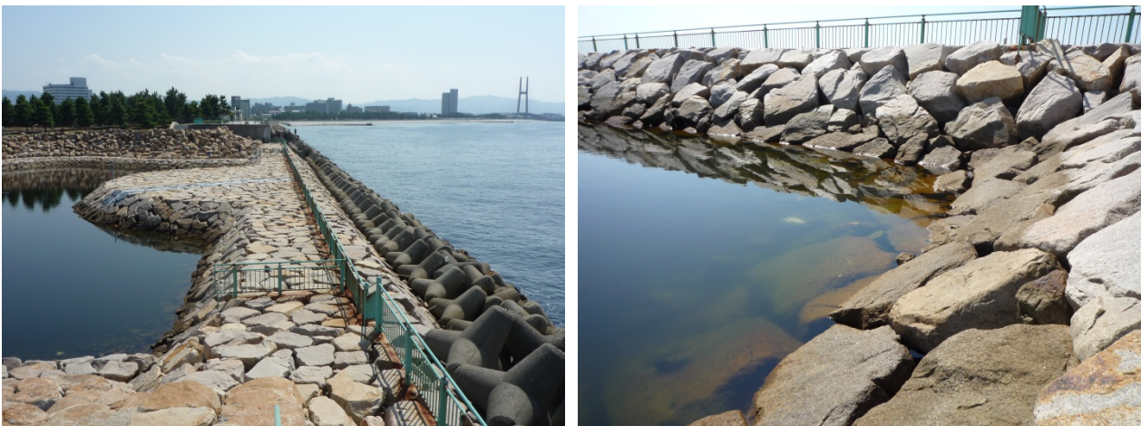
図3.3 修景池と外海の間にある透過堤（左：全景，右：拡大）
