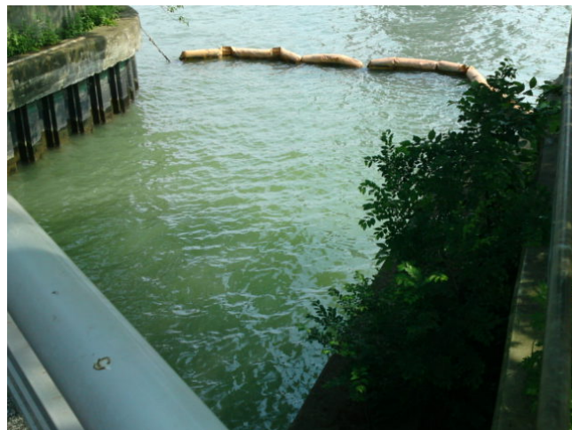
図 4.2 大川本川との接続部 (上左：上流側接続部, 上右：干潮時刻付近 (上流側) 下：下流側接続部)
