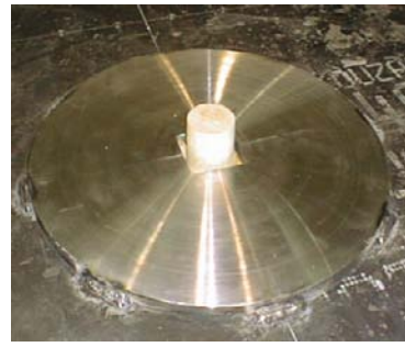
②大斗下ダボ取付
