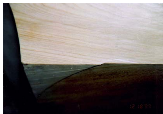
写真 3.2.21 大斗尻のめり込み(南面・西側) 水平載荷実験終了後 12/18 の状況
