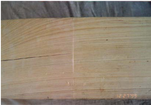
写真 3.2.32 枳肘木下面大斗西側接触部 全実験終了後 12/27 の状況
