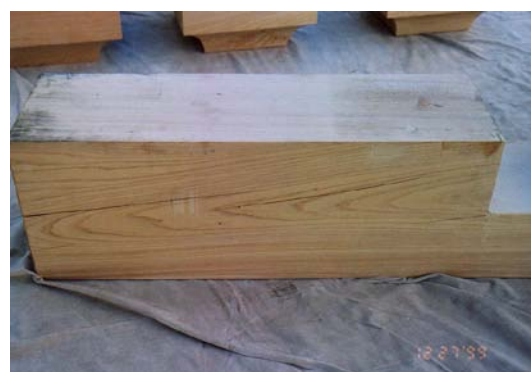
写真 3.2.41 通し肘木のひび割れ(南面・西側) 全実験終了後 12/27 の状況
