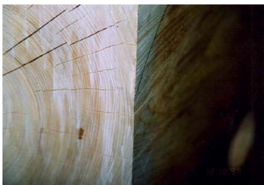
写真 3.2.22 大斗尻のめり込み(西面・南側) 水平載荷実験終了後 12/18 の状況
