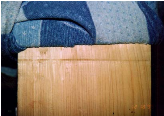
写真 3.2.20 杵肘木下面大斗西側接触部 水平載荷実験終了後 12/18 の状況
