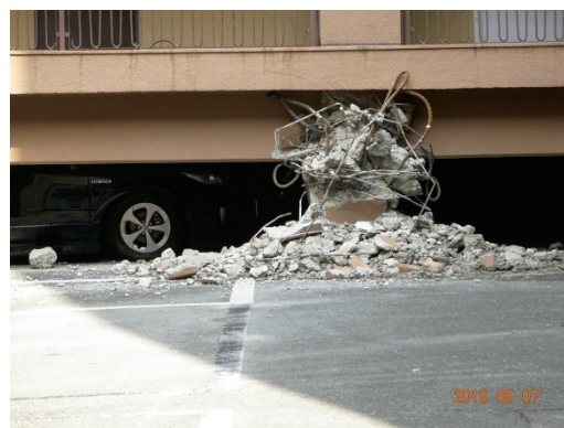
図2 1階ピロティが層崩壊した集合住宅（5/6撮影）
