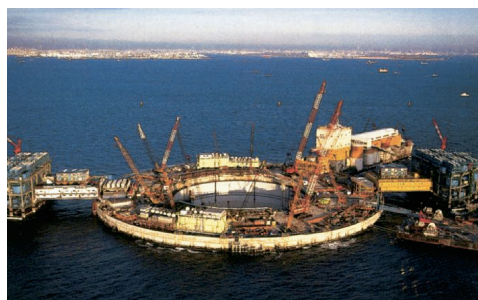
図9 工事中の川崎人工島
